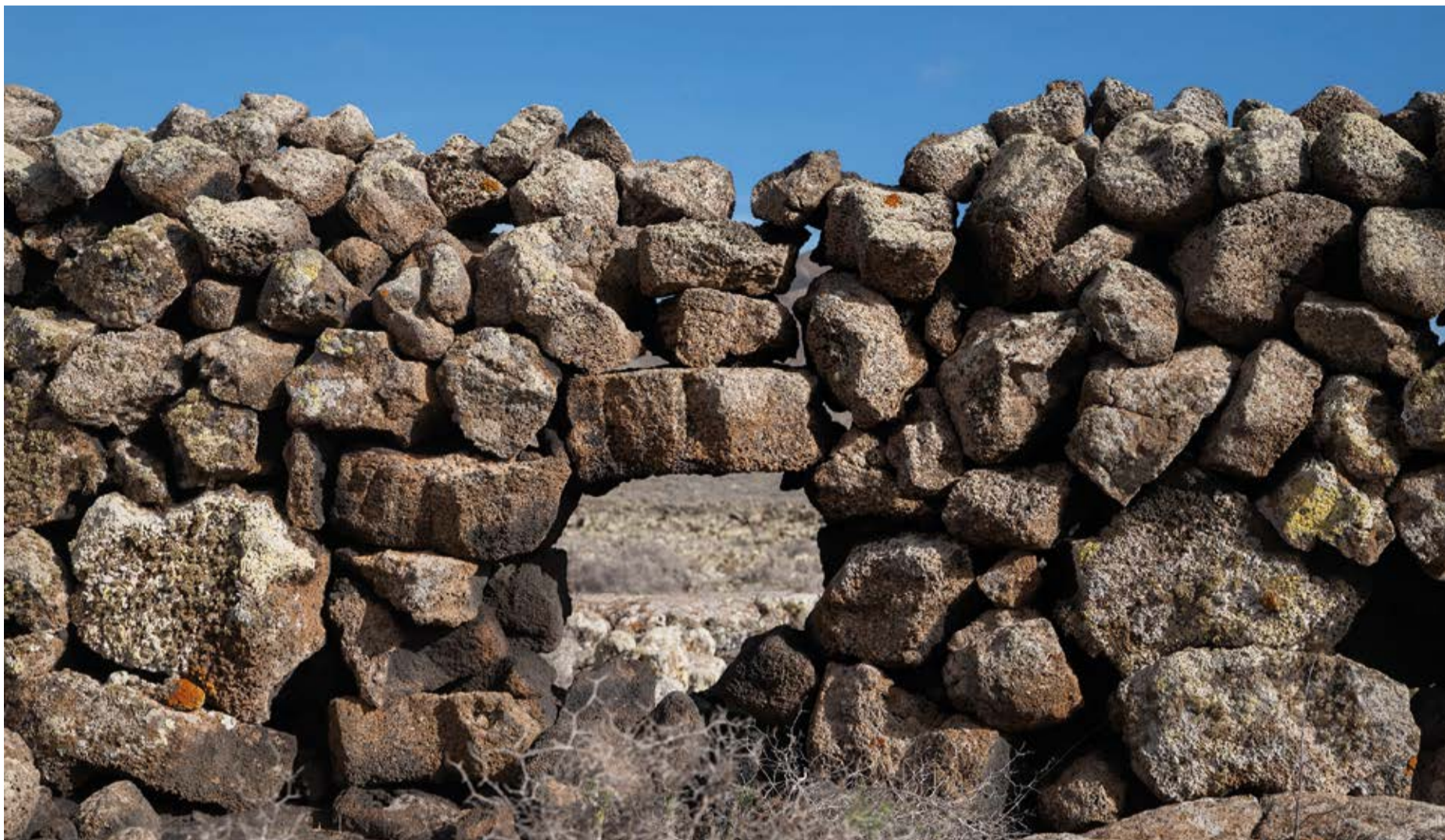
Detalle de un muro de piedra seca en Fuerteventura: Fotos: Carlos de Saá.
