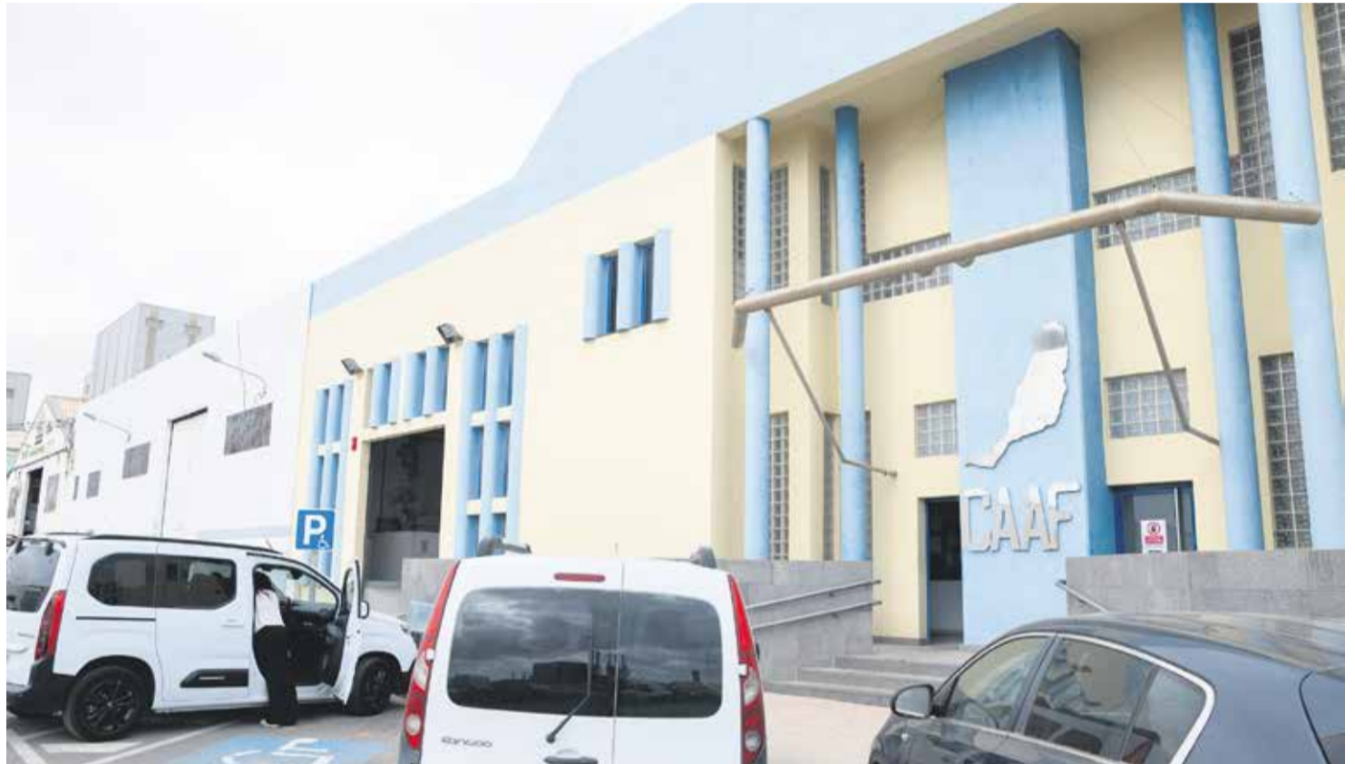
Instalaciones del Consorcio de Abastecimiento de Aguas a Fuerteventura, en Puerto del Rosario. Foto: Carlos de Saá.
