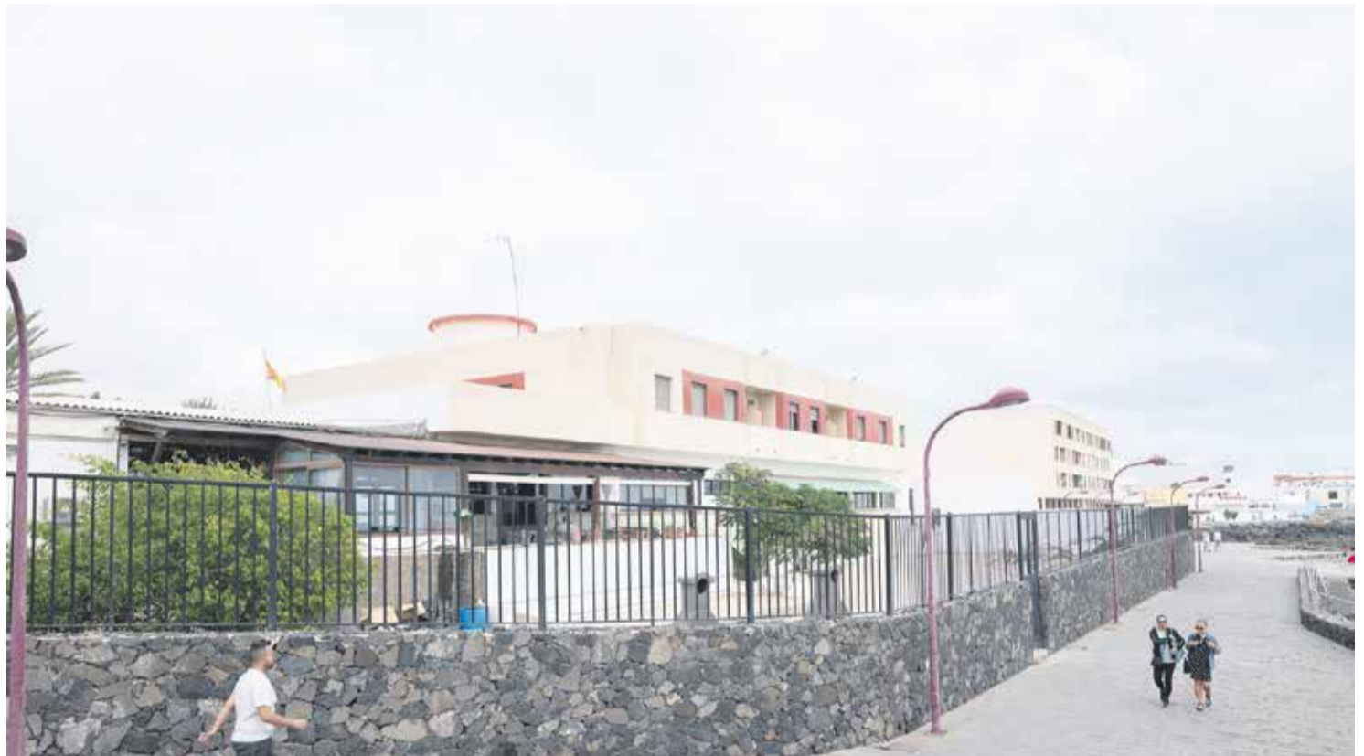
Residencia de Oficiales de Puerto del Rosario. Foto: Carlos de Saá.
