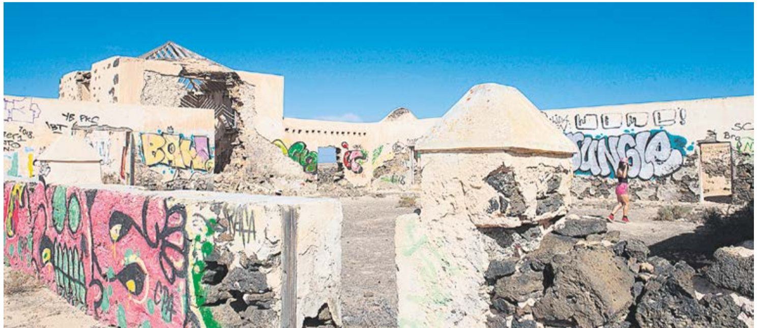
Casa de la Costilla, ejemplo de la arquitectura del siglo XVIII que ha sufrido múltiples actos de vandalismo. Foto: Carlos de Saá.
