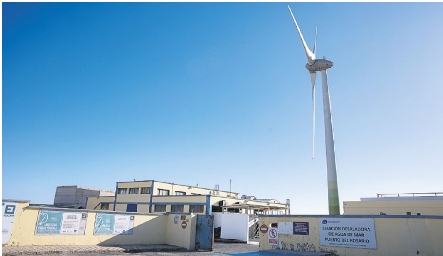
Instalaciones del CAAF en Puerto del Rosario. Foto: Carlos de Saá.
