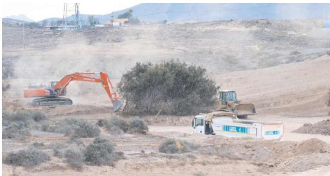
Obras en la presa de Tarajalejo.
