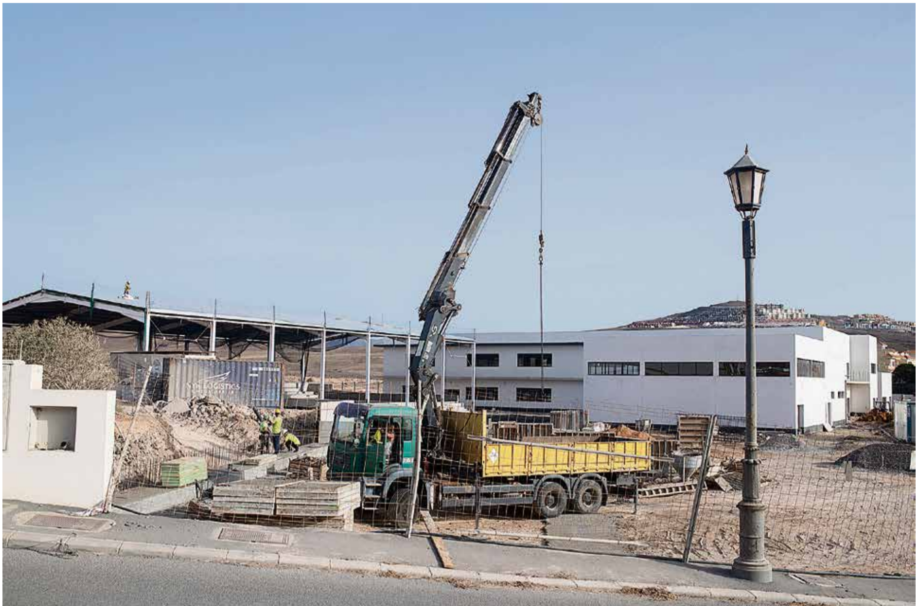
Obras del colegio de El Castillo. Foto: Carlos de Saá.
