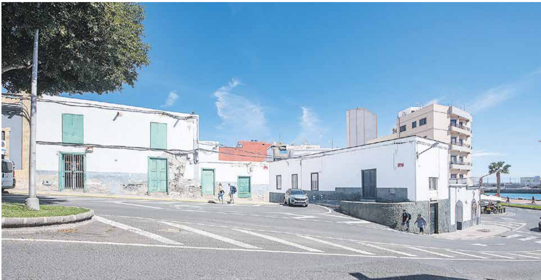
Imagen general de la zona en la que se encuentran los tres edificios que adquirirá el Cabildo de Fuerteventura. Fotos: Carlos de Saá.
