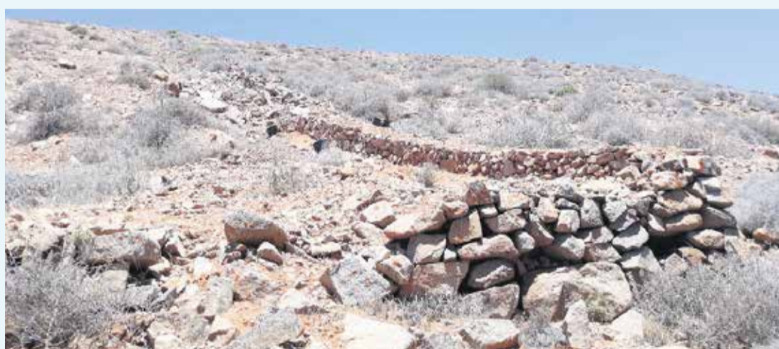
La restauración de muros de mampostería en seco se lleva a cabo con las piedras existentes a pie de muro.
