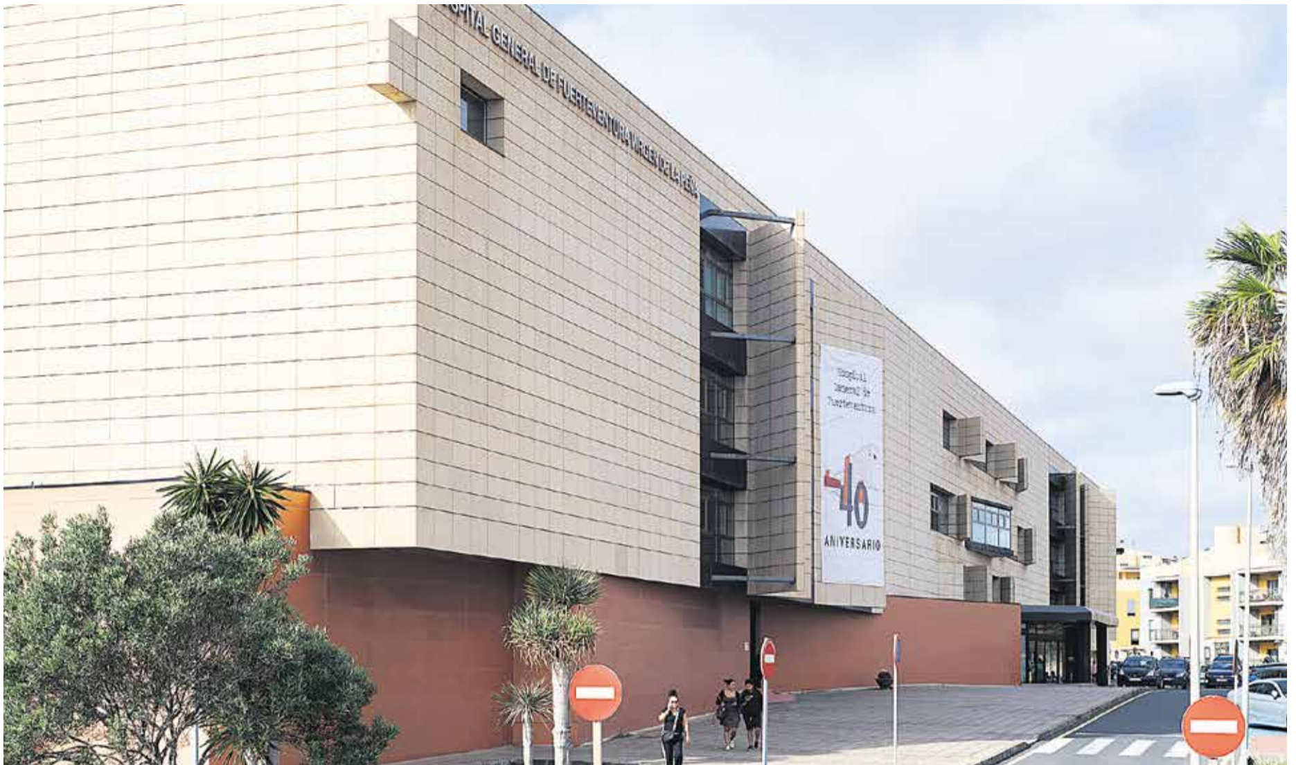
Hospital General de Fuerteventura. Fotos: Carlos de Saá.
