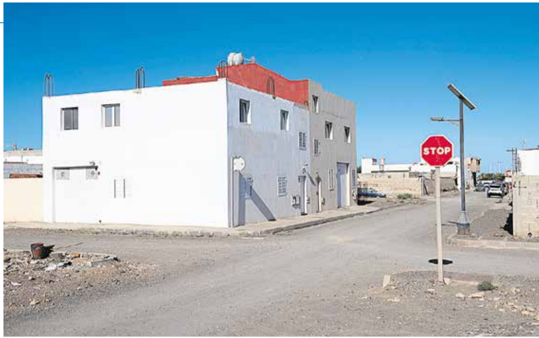
Calles sin asfaltar en Llanos de La Mareta.
