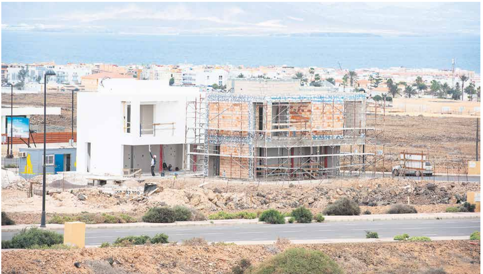
Obras de una villa en la urbanización Panorama Tres Islas, en Corralejo. Foto: Carlos de Saá.
