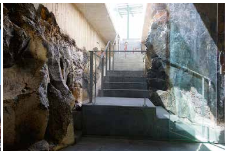
Detalle de la escalera de acceso a Sala Umbría.
