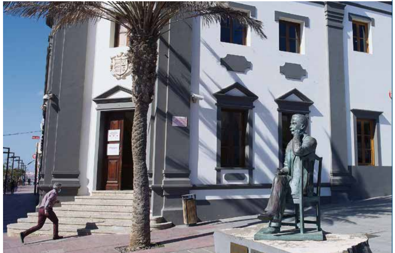
Sede del Cabildo de Fuerteventura. Foto: Carlos de Saá.
