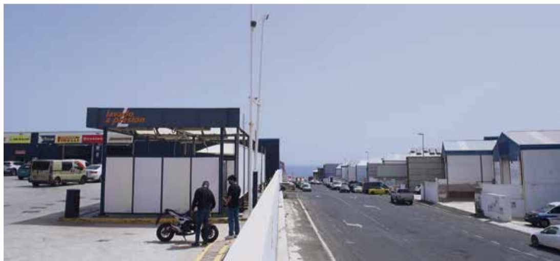
Los empresarios piden mejoras en la iluminación y más seguridad.
