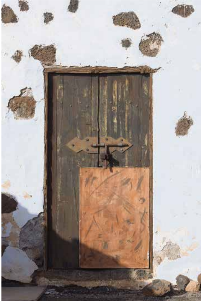
La puerta rota se ha parcheado con una pieza de madera.
