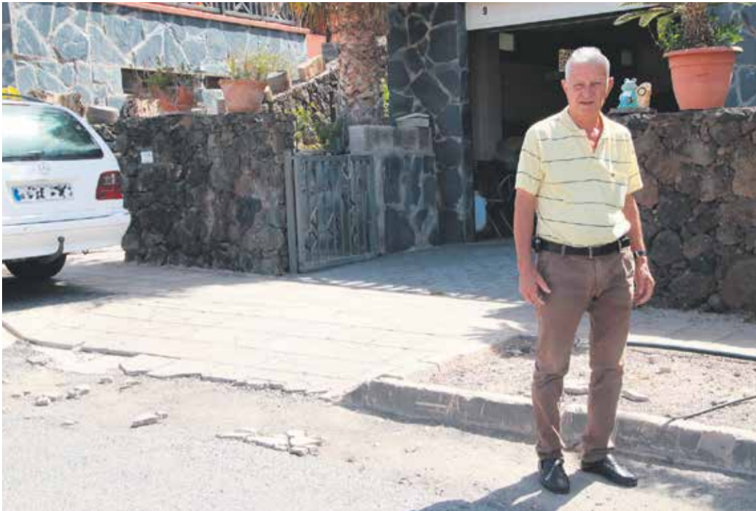
Julián a las puertas de su residencia. La falta de mantenimiento en el acceso a la vivienda es notable.
