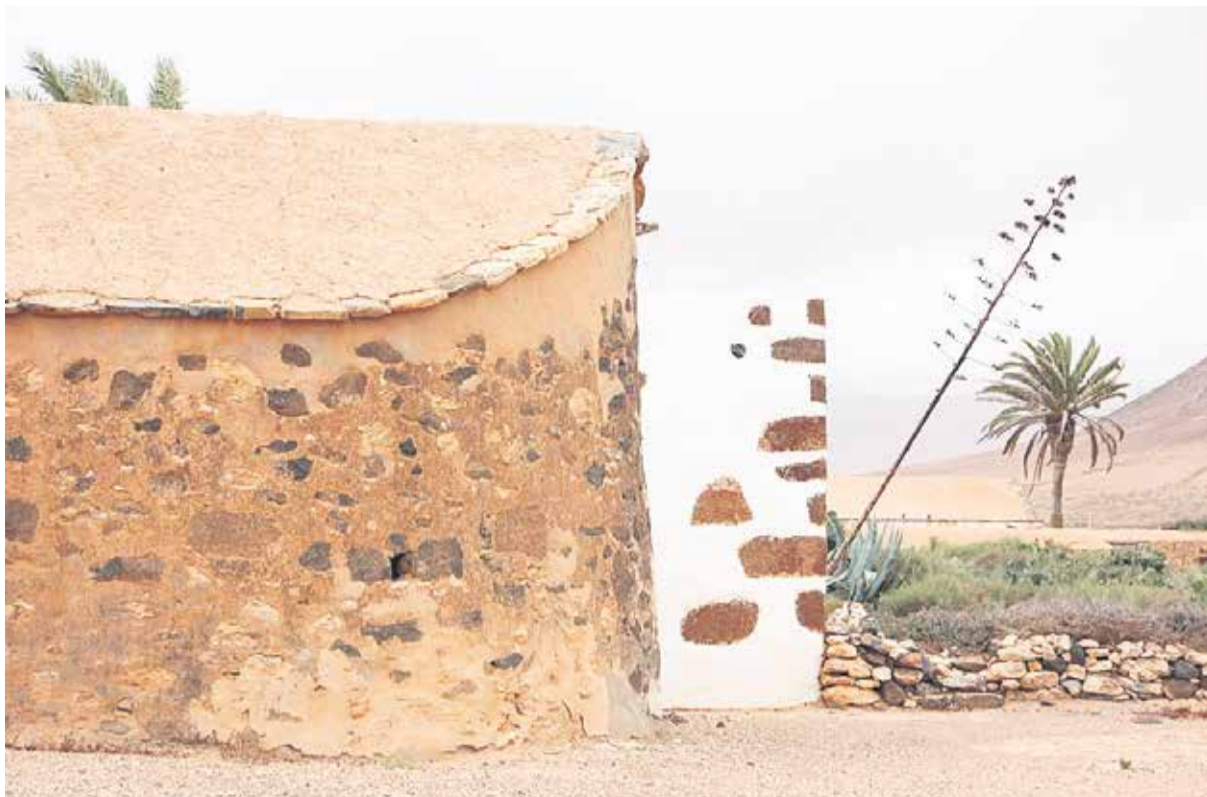
Parte de fachada norte de edificación tradicional ubicada en el eco-museo “La Alkogida” del pueblo de Tefía, Puerto del Rosario. La formalización de este espacio se aleja de las líneas rectas, contrastando con el resto del espacio residencial.
