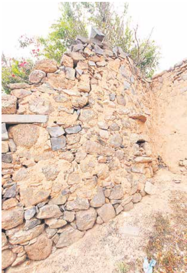
Muro curvo hacia espacio interior en construcción tradicional en calle Vallechico del pueblo de Vallebrón, La Oliva. Se altera el espacio interior rectangular sólo en este muro orientado al poniente.
