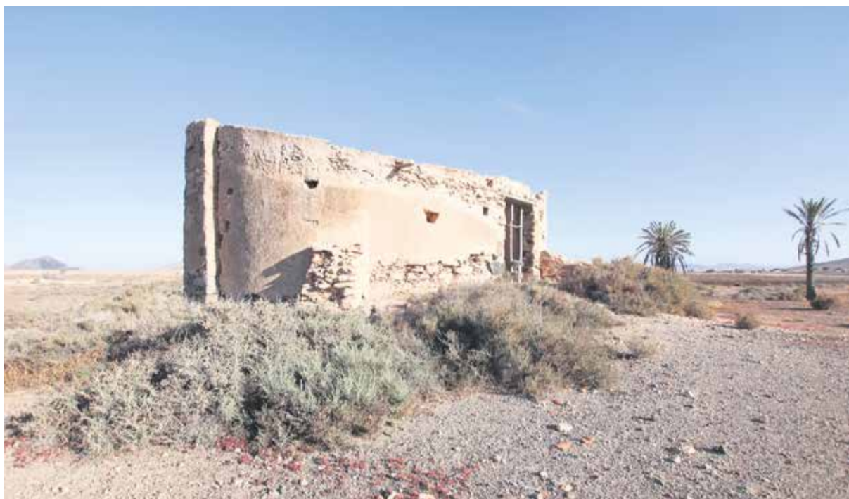
Fachada del taro de Tegurey de grandes dimensiones situado en Tuineje, con casi 13 metros de diámetro interior sin pilares interiores.
