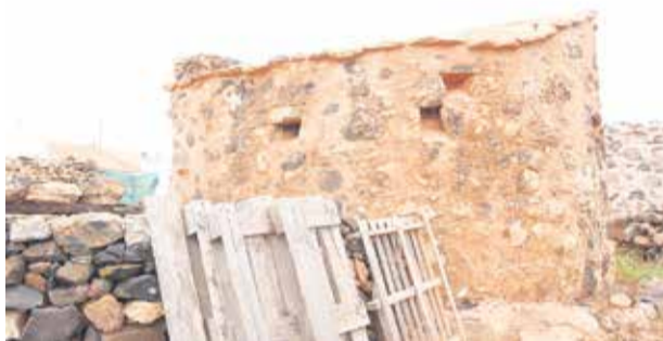
Muro curvo de pequeña edificación tradicional ubicada en el pueblo de Ampuyenta del municipio de Puerto del Rosario. Disposición libre de pequeños huecos en su fachada norte.
