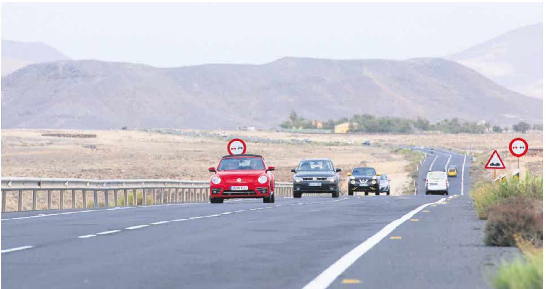
Estado actual de la carretera. Foto: Carlos de Saá.
