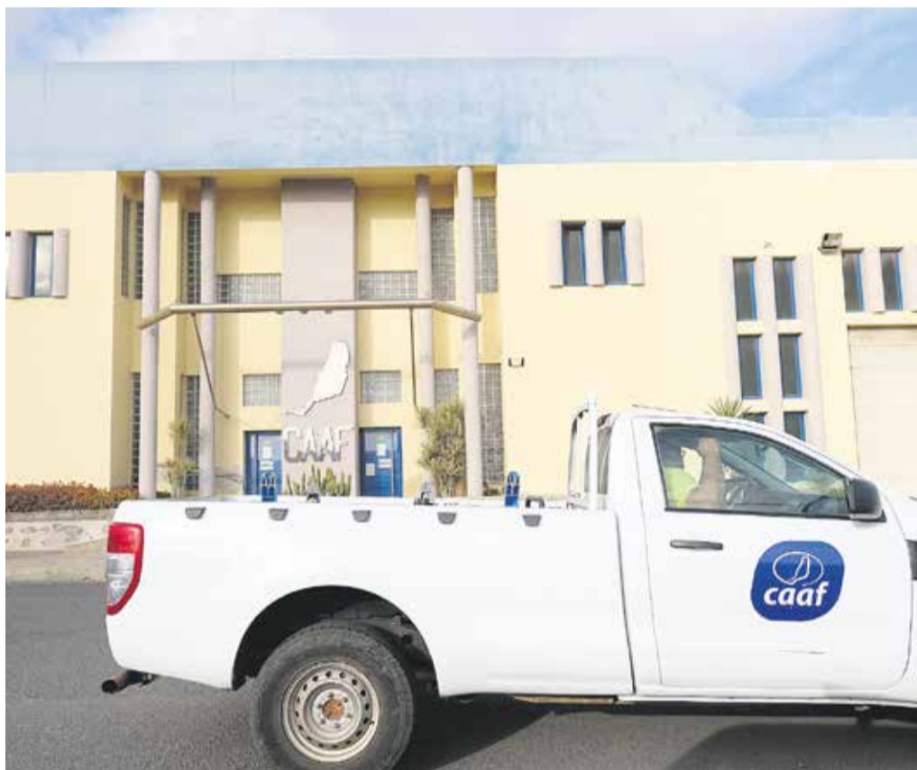
Sede del Consorcio de Abastecimiento de Aguas a Fuerteventura. Foto: Carlos de Saá.
