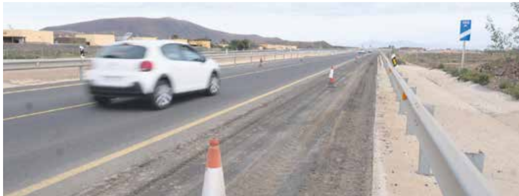
Tramo de la autovía a Corralejo. Foto: Carlos de Saá.
